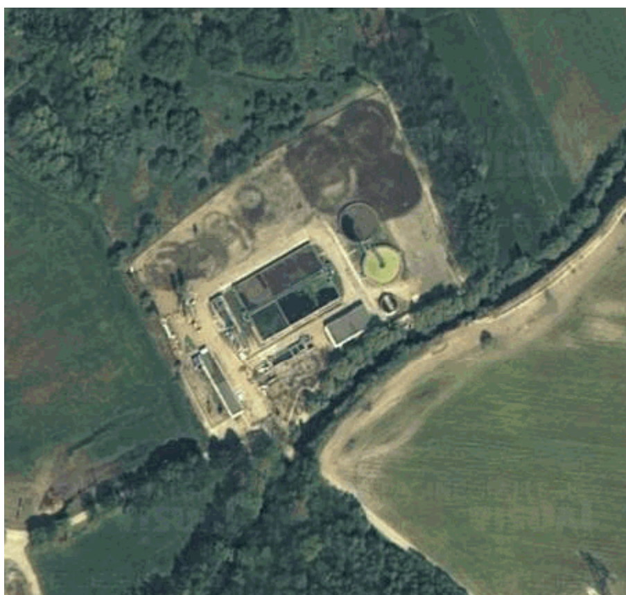
Figura 29. Foto aerea del Depuratore di Casalzuigno
